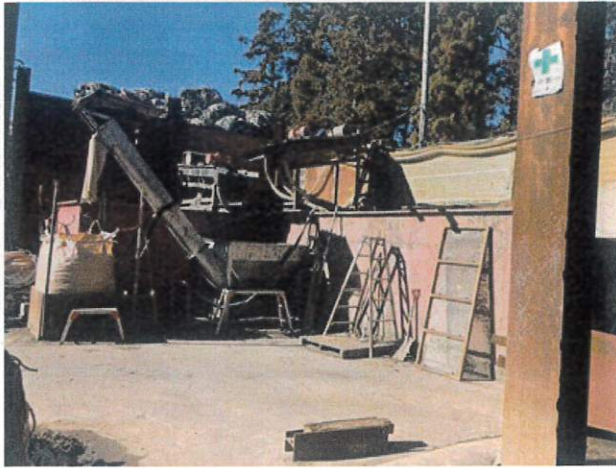
①水槽（循環水貯留水槽）
